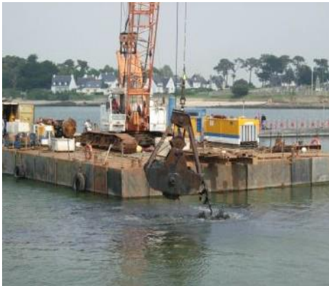
Fig8 : Dragage à benne
