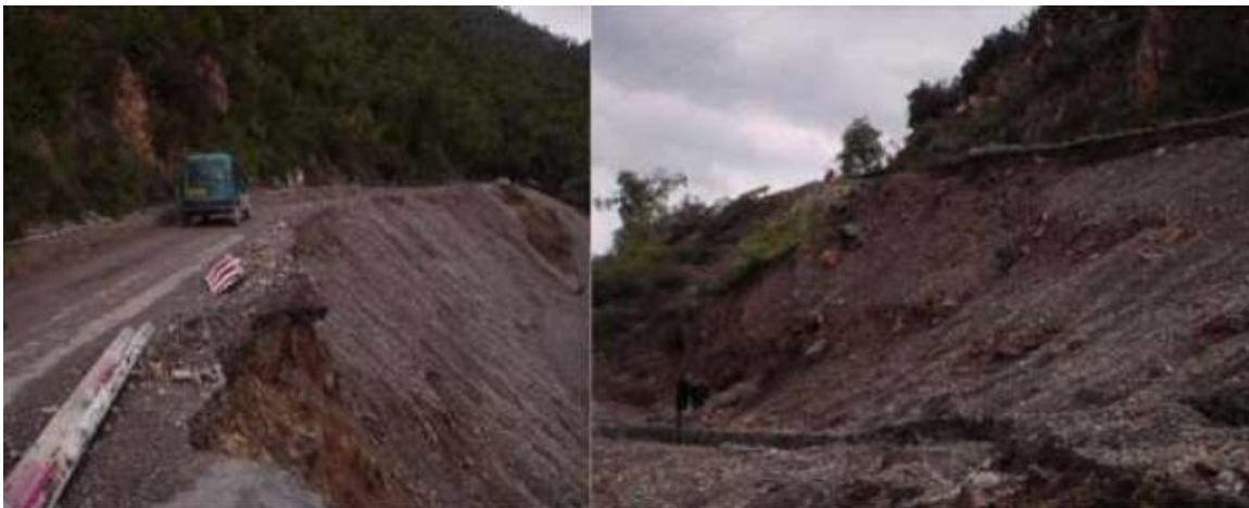
Figure I.15 : Route affecté par le glissement à Bejaia.
