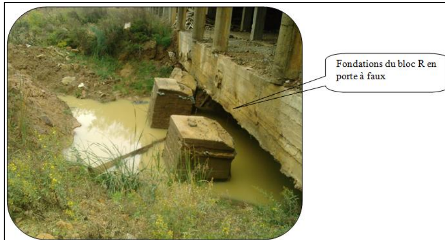
Figure III.24 : Fondations du bloc R en porte à faux.
