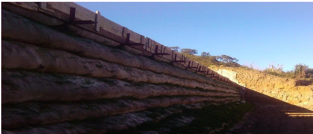
Figure III.12: Vue d'un mur en géotextile en cours de réalisation à la RN24 SAKET (Bejaia)
