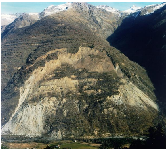
a : glissement de la Clapière en France
