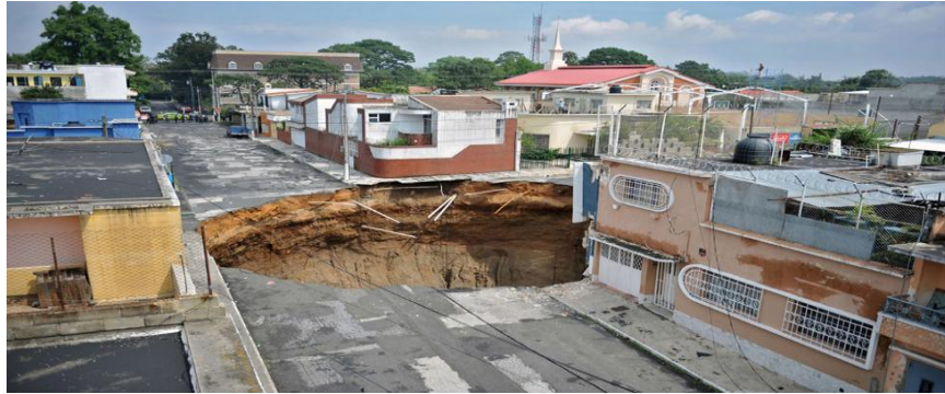
Figure I.9 : Effondrement à Guatemala
