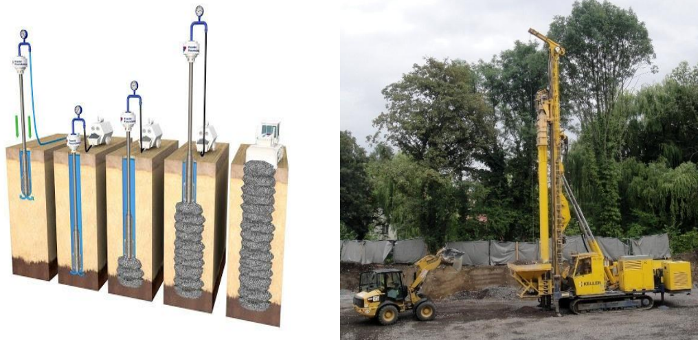
Figure III.32: réalisation des colonnes ballastées
