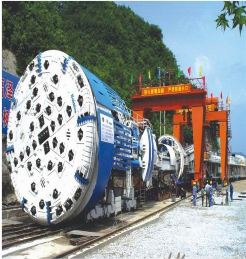
Figure I .5. Creusement en Tunnelier ou machine à attaque globale (TBM) [7]
