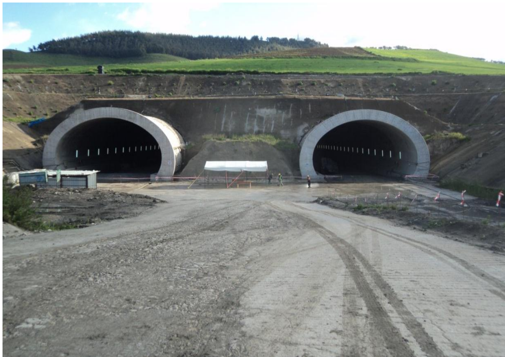
Figure IV.1. Portails sud de tunnels T4 (photo sur site).
