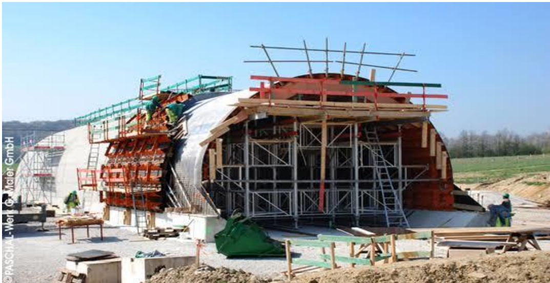
Figure II.12 Exemple de coffrage de tunnel
