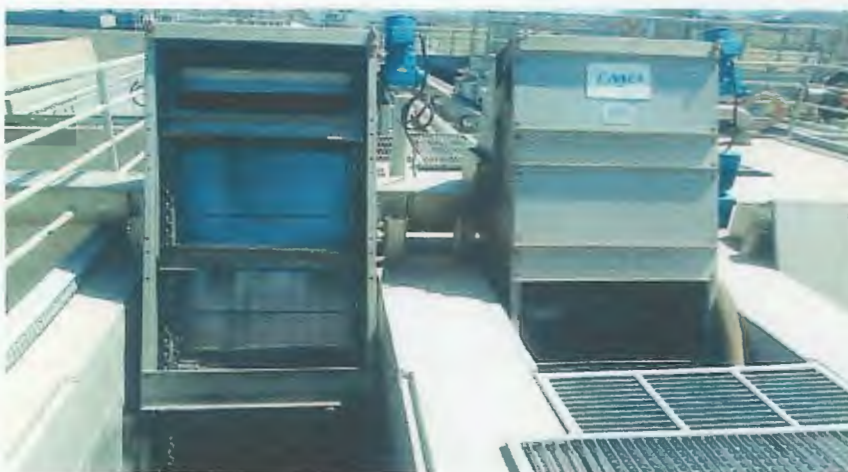
Figure 5 : Dégrilleur fin
