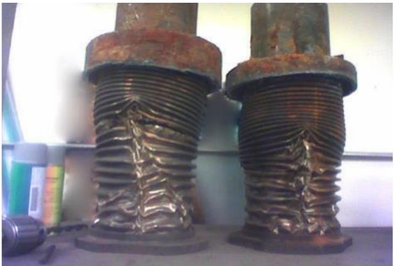
Figure (I. 4) : La détérioration des joints d'expansion suite à un aigu coup de bélier
