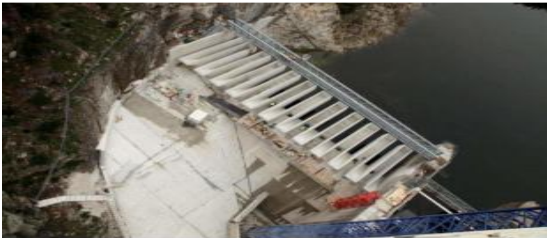
Figure I.27: Déversoir en touches de piano (Djedia.R, 2016).
