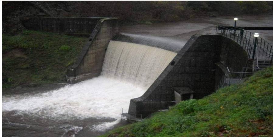
Figure I.13 : Evacuateur à seuil libre ( www.barrages-cfbr.eu/ ).
