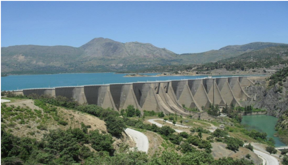
Figure I.4 : Le barrage d'Erraguene contrefort, willaya de Jijel ( www.soudoud-dzair.com/ ).
