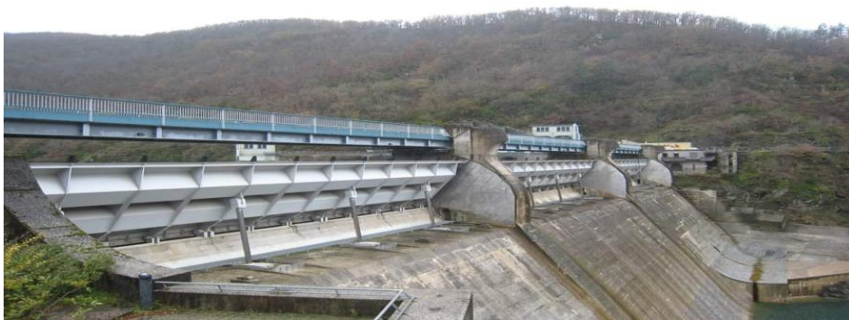
Figure I.14 : Evacuateur à seuil vanné ( www.barrages-cfbr.eu/ ).
