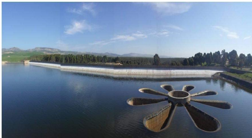
Figure 16 : Evacuateur de crue tulipe en forme marguerite, de barrage de Sarno willaya de Sidi Belabbes ( www.soudoud-dzair.com/ ).
