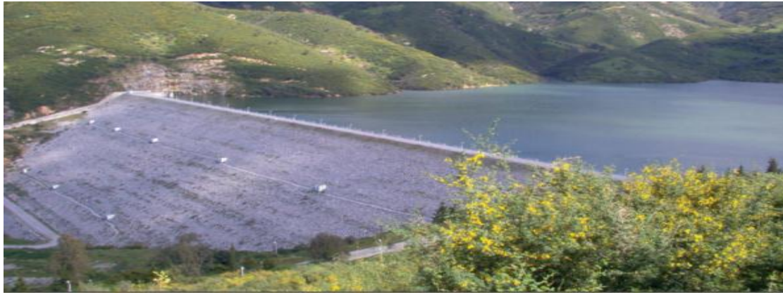
Figure I.9: Le barrage d'el agrem a Jijel en enrochements compactés avec masque d'étanchéité amont en béton armé (Abdellaoui.M, 2012).
