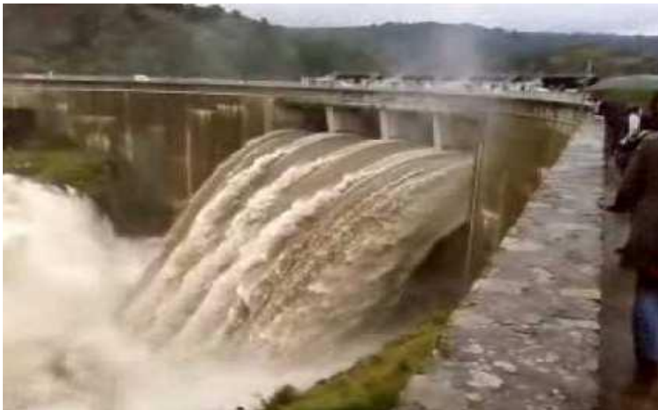
Figure I.19: Evacuateur de crue du barrage Grangent France (Zerguit.N, 2018).
