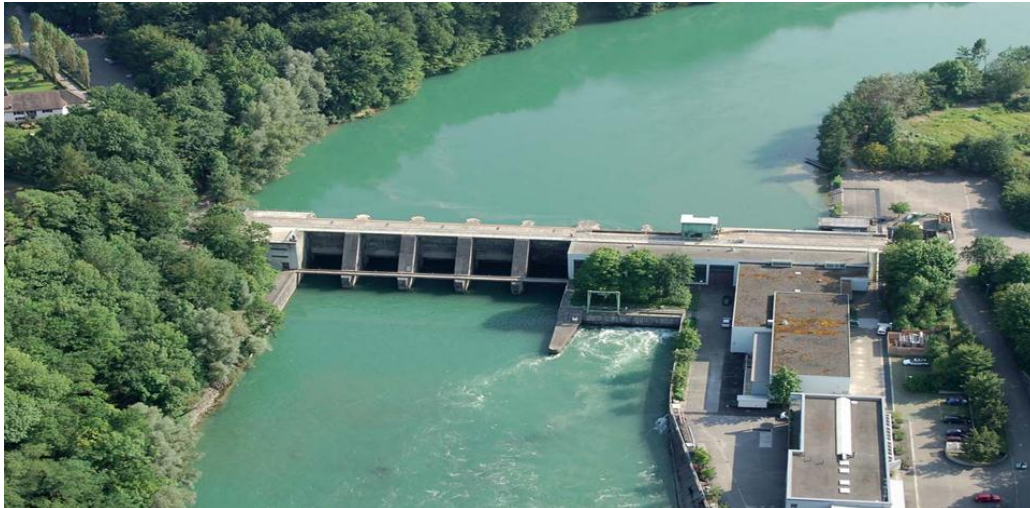
Figure I.10: Barrage mobile Bremgarten-Zufikon, en suisse ( www.swissdams.ch/fr ).
