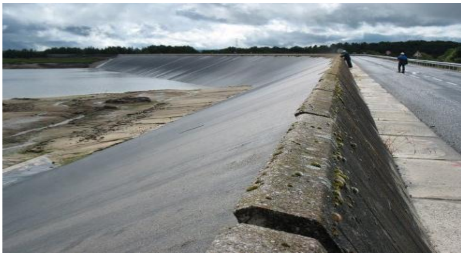
Figure I.7: Barrage de Monnès a masque amont en béton bitumineux en France ( www.barrages-cfbr.eu/ ).
