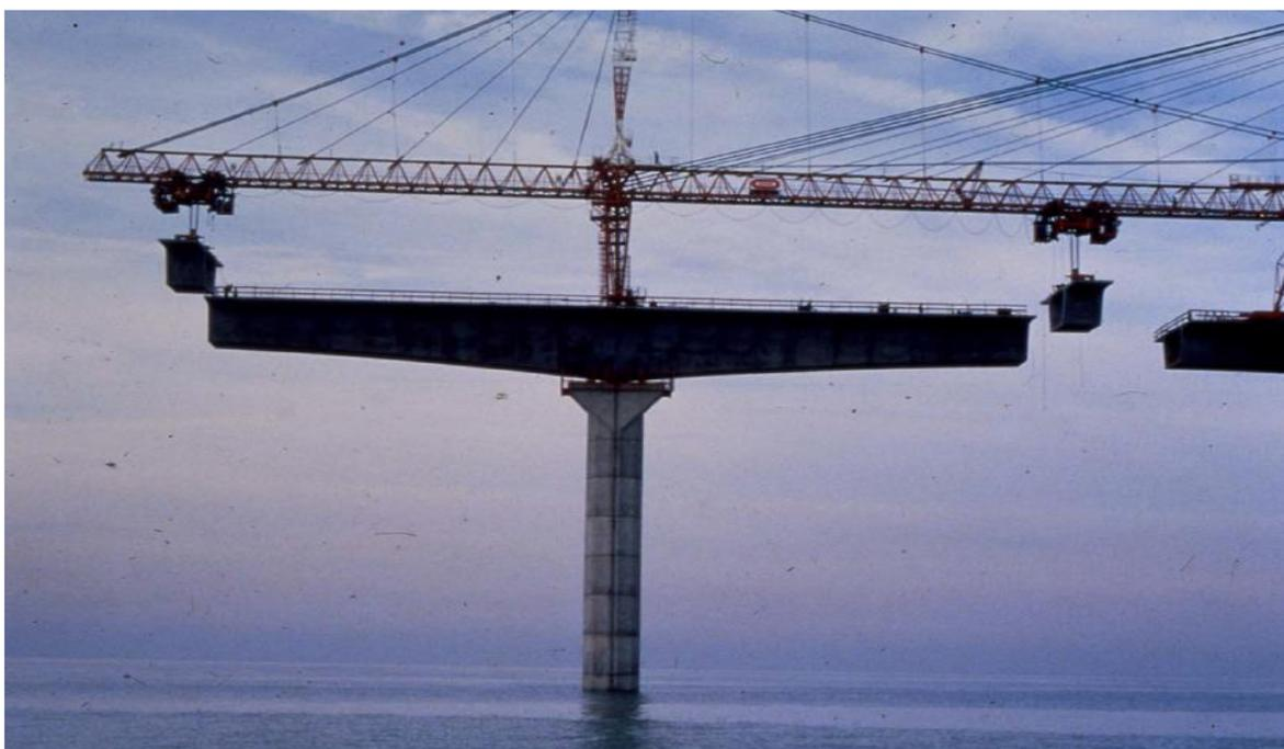
**Figure V.1.** *Pont construit par encorbellement en voussoirs préfabriqués posés par poutre de lancement*
