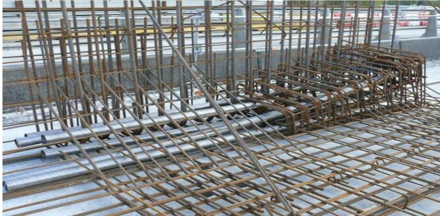
**Figure.VII.8.** *exemple de ferrailage d'un bossage*
