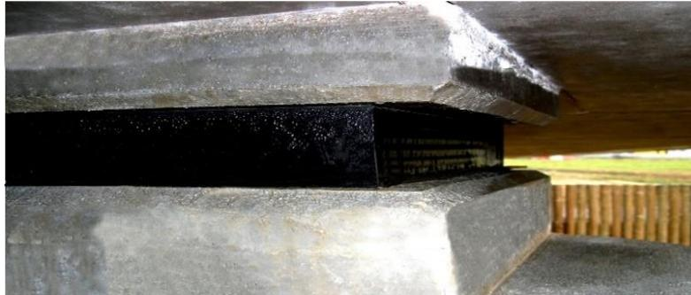
**Figure.X.3.** Appareil d'appui en élastomère fretté
