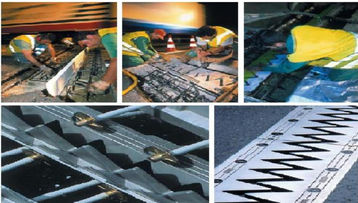
**Figure.X.2.** joint de chaussée Wd230
