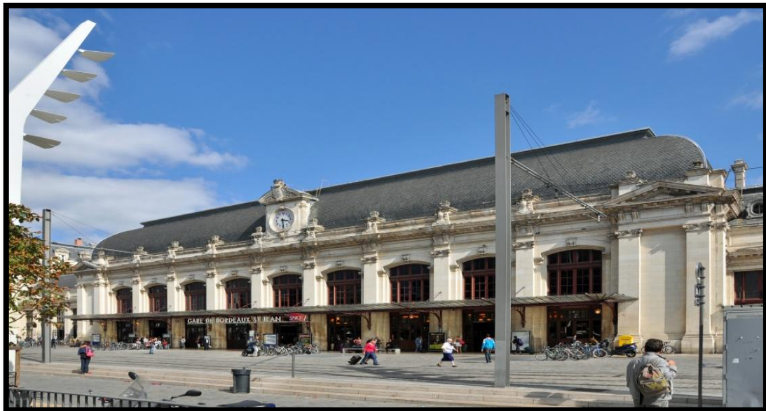
Figure I.20 : Gare de Bordeaux-Saint-Jean (France).
