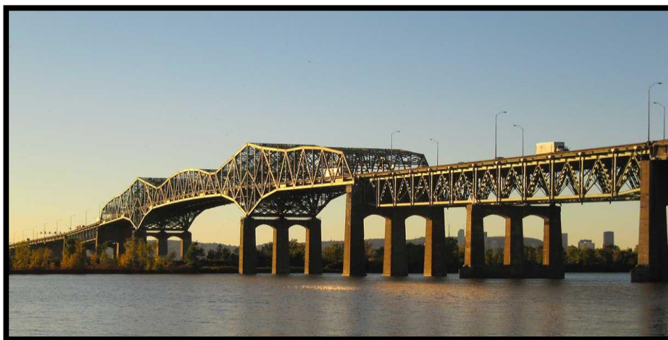
Figure I.1: Réfection du pont Champlain en BHP.
