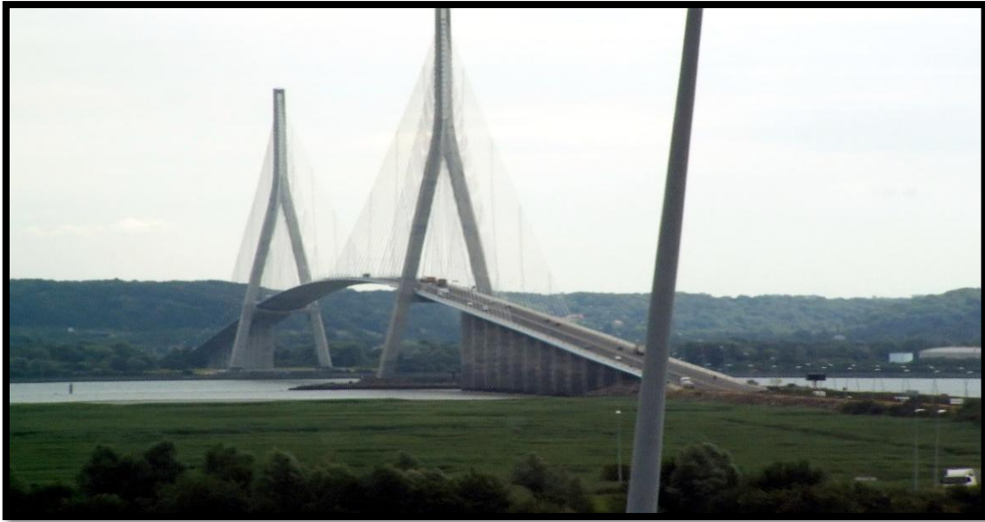
Figure I.21 : Pont de Normandie (France).
