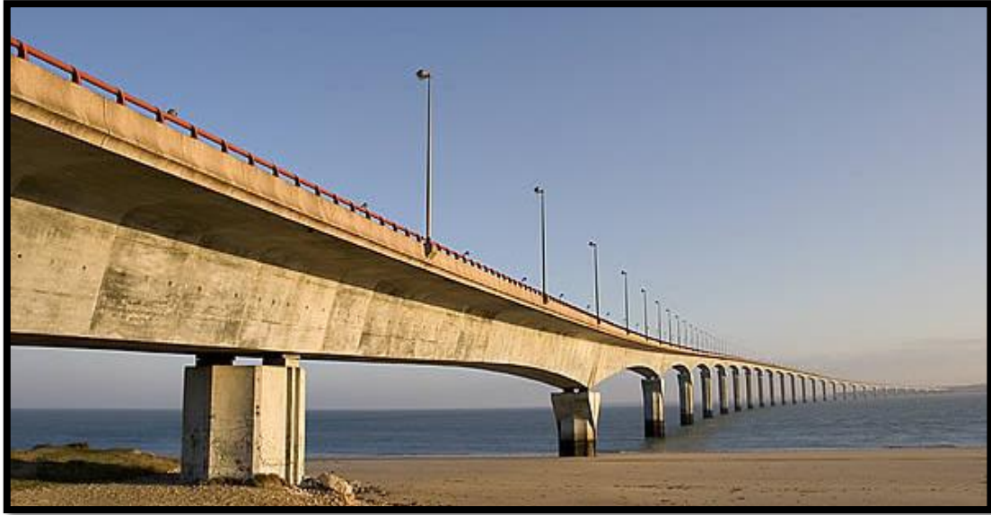
Figure I.19 : Pont de l'île de Ré.
