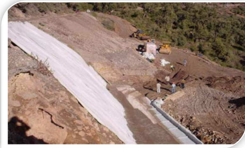
Photo.VI.5.Mise en œuvre du géocomposite de drainage (site web 2019)
