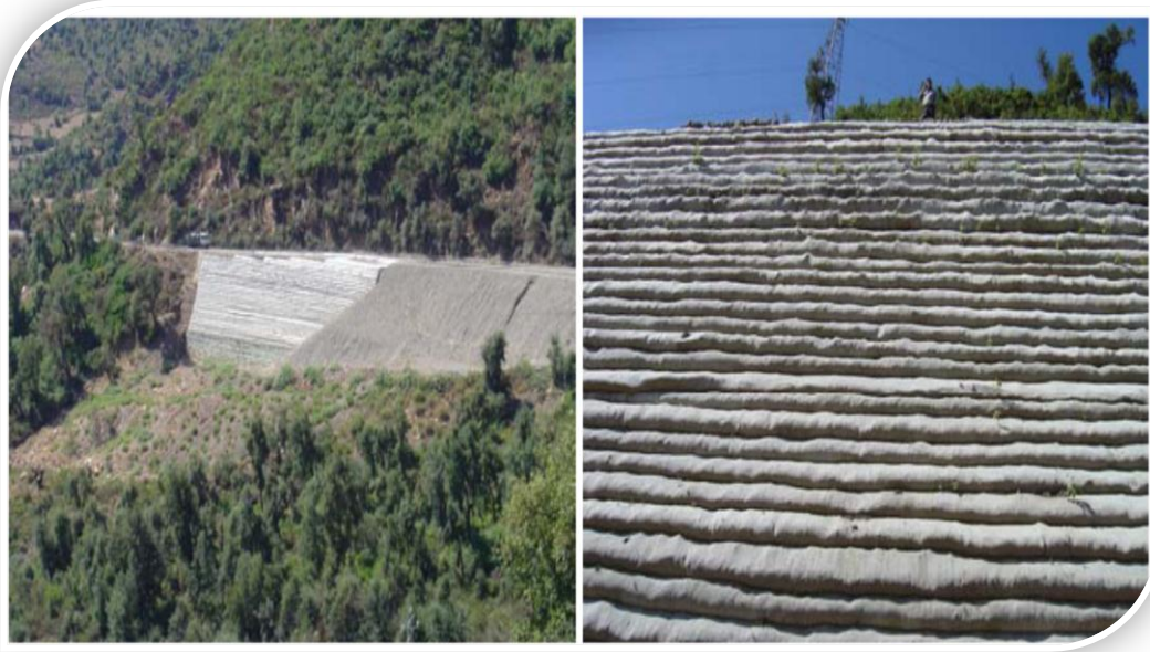
Photo.VI.7.Construction de l'ouvrage par couches (sit web 2019)
