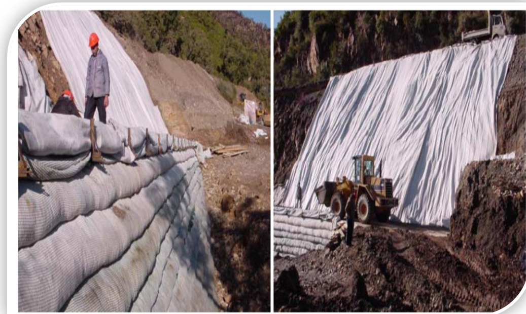
Photo.VI.6.Vue de l'ouvrage achevé (site web 2019en Tunisie)
