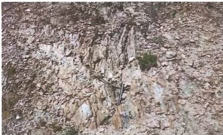
Photo 4: Surface de masse rocheuse présente une face altérée
