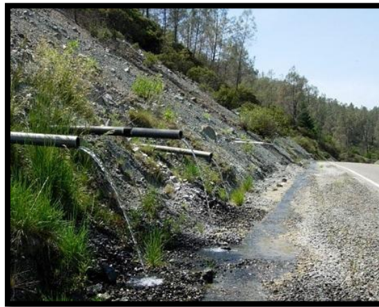
Figure.I.7. Drainage de talus par barbacanes (Desodt, 2017)
