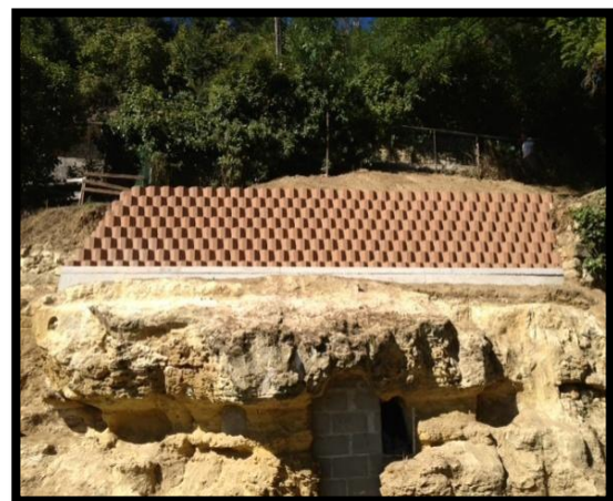
Figure.I.9. Confortement des pentes par des murs de soutènement (Desodt, 2017)
