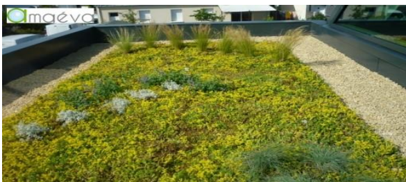
Image 8 : Toit végétal extensif
