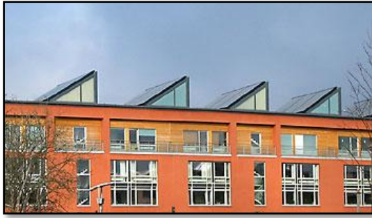
Figure 4.10. : Toiture avec des panneaux photovoltaïques (Source : http://www.ecolodujour.com )
