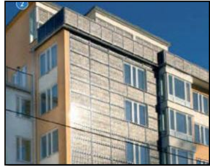
Figure 4.11. : Façade avec des panneaux solaire (Source : Gaffney et Al. 2007)
