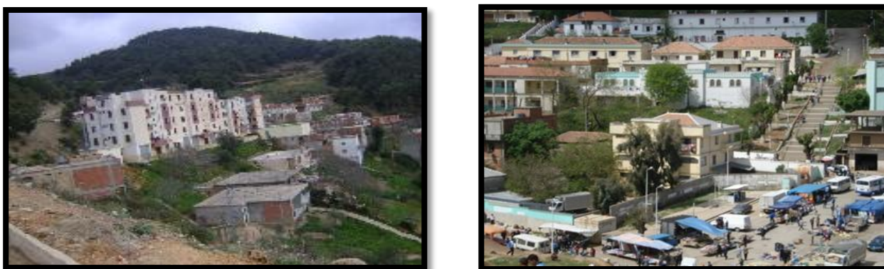
Figure n°12: Type de l'habitat, source : auteur 2018
