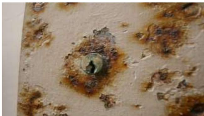
**Figure II.12** : La corrosion sélective.
