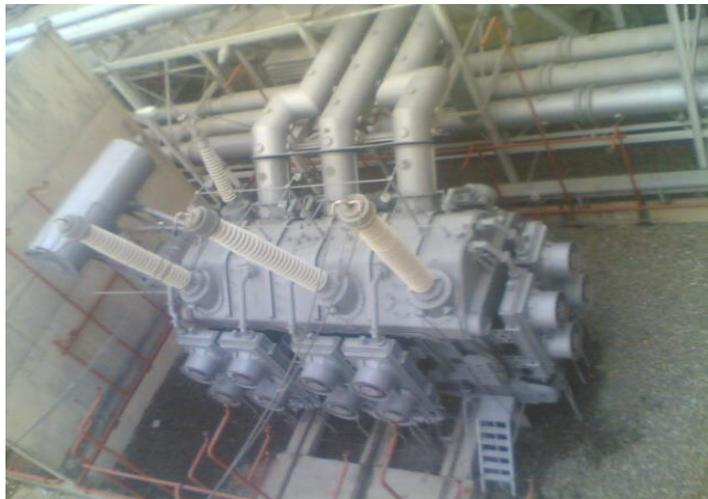
**Figure (IV.1) : Transformateur** de la centrale de Jijel
