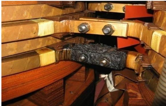
**Figure(III.5)** Point chaud sur connexion boulonnée
