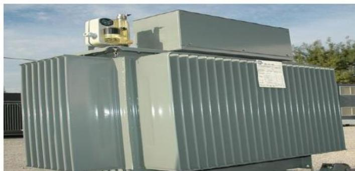
**Figure (I.25) :** La cuve d'un transformateur de puissance.
