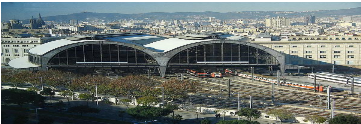
Figure 22Gare ferroviaire de Barcelone
