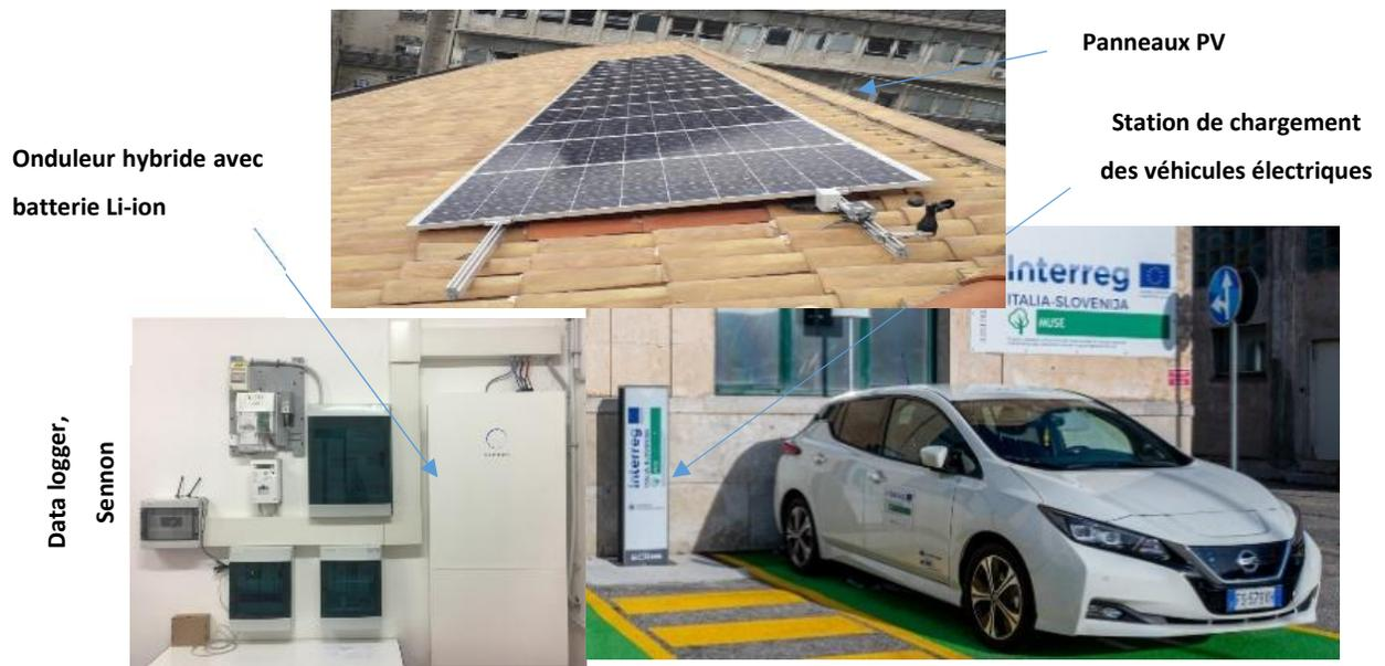
**Figure 4.2:** La station de chargement des véhicules électriques à base d'un MG a l'Université de Trieste, Italie.
