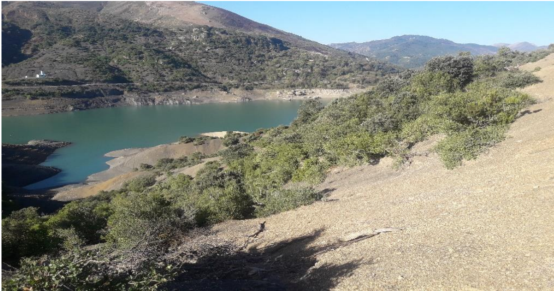
Figure 68 : barrage d' Erraguen
