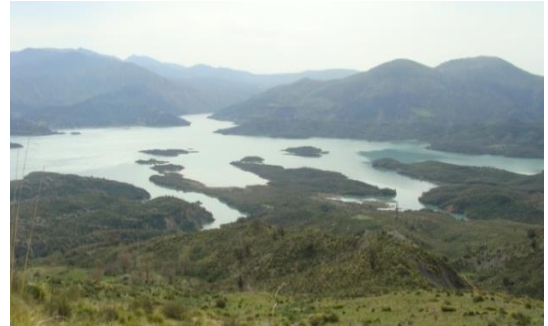
Figure 40 : vue sur la cuvette du barrage d'Erraguen de la Branche Oued Labsat
