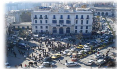
Figure 35: La Place du 1er Novembre 1954 (La Brèche) délimitée par des équipements avec une architecture coloniale (la grande poste) , source ; AMIRECHE Toufik , memoire de magister approche des espaces publics urbains : cas de la ville nouvelle ali mendjeli
