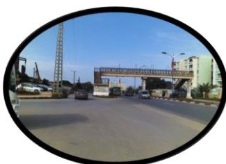
Figure 82: La passerelle, source : auteur
