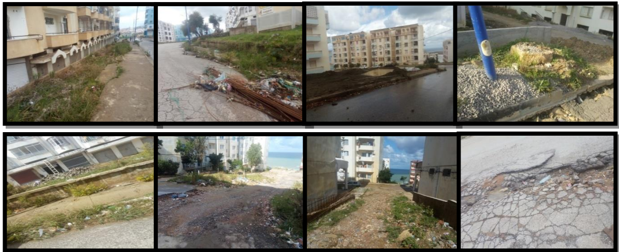
Figure N°50 : L'état des trottoirs et les voies
