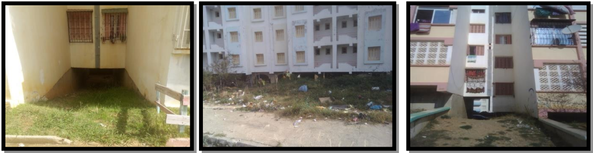
Figure N°56 : Les vides sanitaires Source : Auteur
