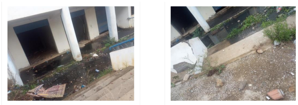
Figure N°54 : L'état d'assainissement au site
