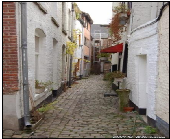
Figure n °15: La rue hors château à Belgique Source : www.lavilledeliegeetcesquartiers.blogspot.com
