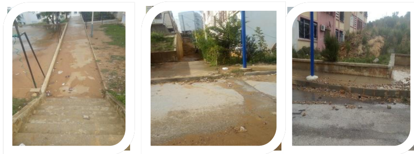
Figure N°53 : L'état des espaces piétonniers
