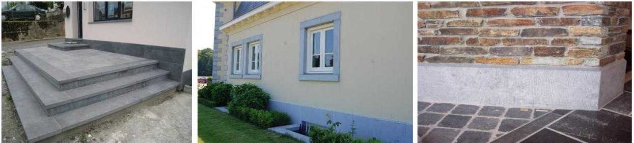
Figure 68-70 : les exemples des soubassements.
