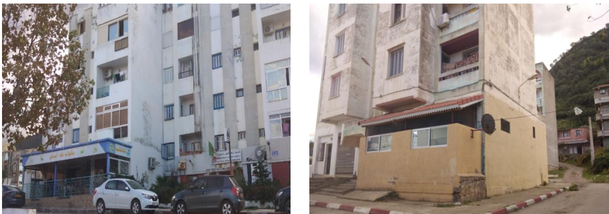
Figure 23 : modification sur la façade principale
