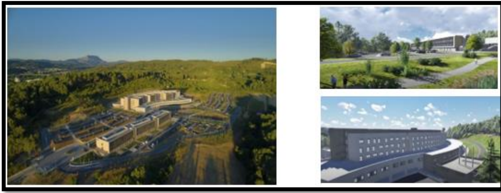
Figure 27 : vue générale de l' hpp de Provence.
