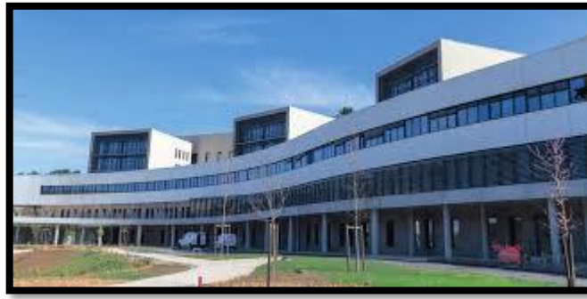
Figure 32 : la façade sud de l'hôpital prive de Provence. Source : hôpital-prive-de-provence.com consulte le 15-08-2020
