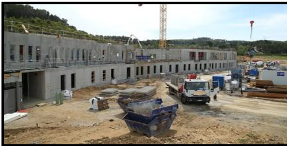
Figure 30 : le chantier de l'hôpital privé de Provence.
