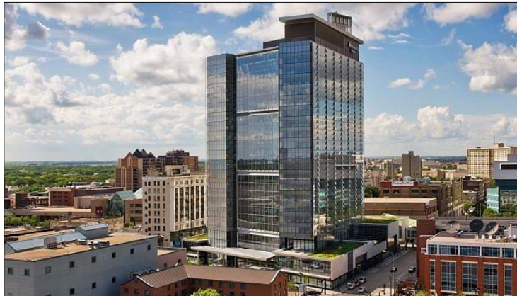
Figure III-11 : Le nouveau siège social de Manitoba Hydro.
