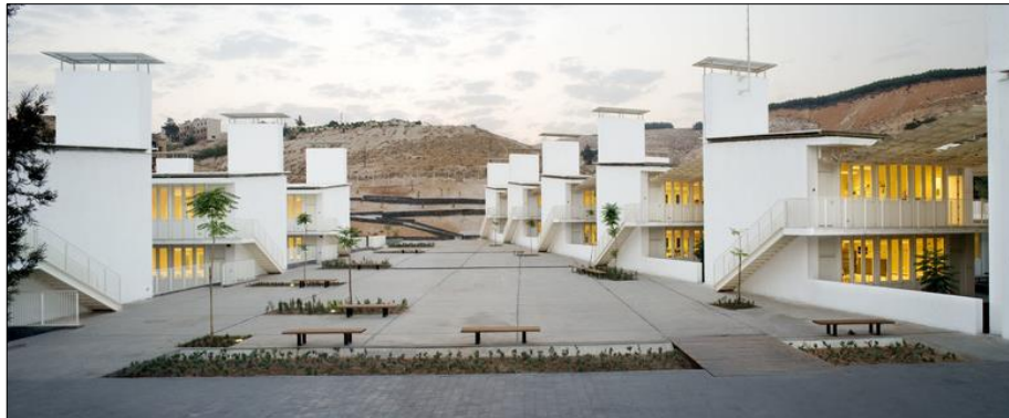
Figure III-01 : La cour du lycée Charles de Gaulle de Damas.
