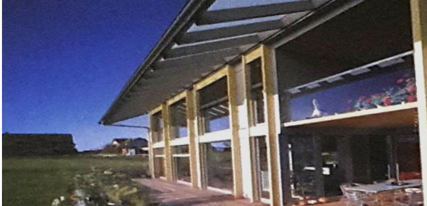
Figure [I 11]: Maison à basse énergie en Suisse.
