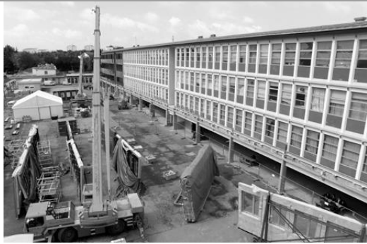
Figure 4.9: les travaux de réhabilitation.
