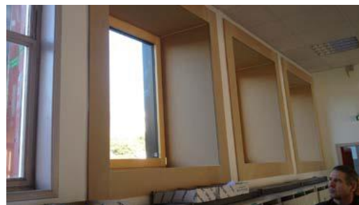
Figure 4.17:Habillage intérieur en médium
