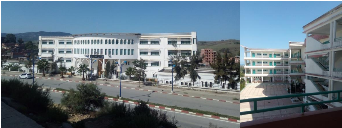
Figure 5 .1: vue sur le lycée.
