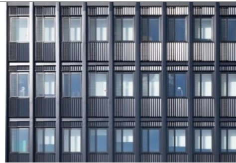
Figure 4.13: façade du bâtiment B après les travaux.
