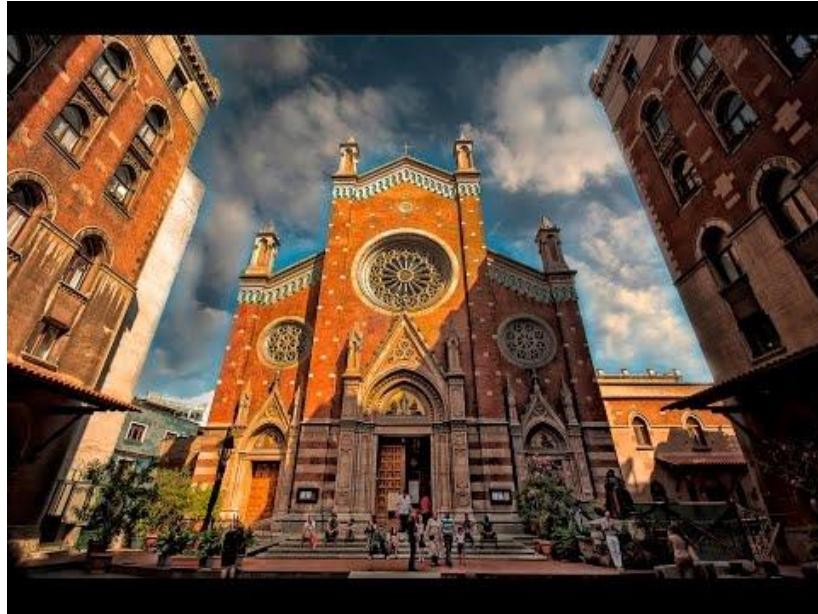
Photo 12 : vue de face d'église st Antoine.
