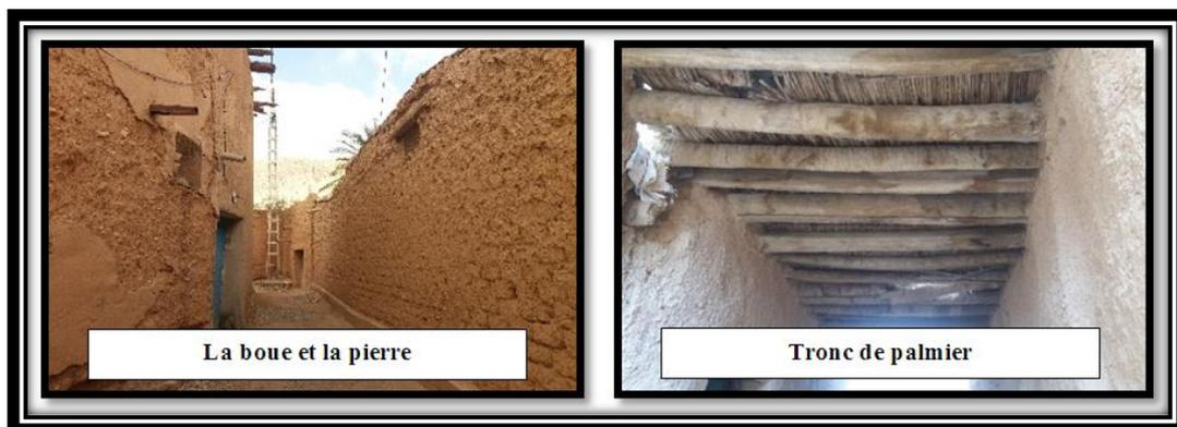
Photo n° 13 : Matériaux locaux de construction (boue et la pierre, tronc de palmier)
