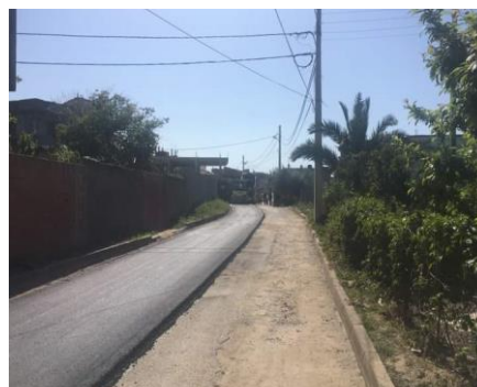
Figure [5.8] : revêtement des routes.
