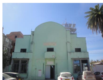
Figure [5.10] : réhabilitation de l'église.
