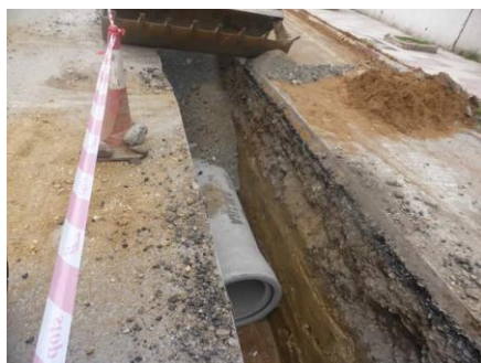
Figure [5.7] : travaux d'assainissements.
