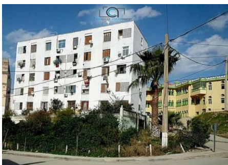
Figure [5.9] : réhabilitation des 100 logements.
