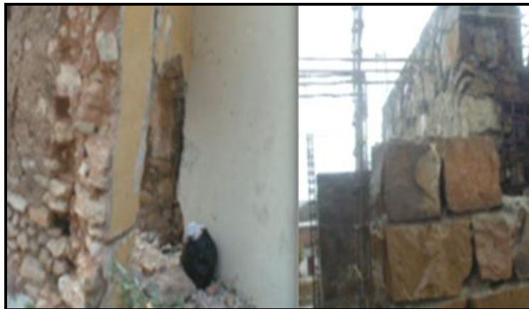
Figure20: Bâtie ancien (gauche) et bâtie récent (droite) en moellon de pierre
