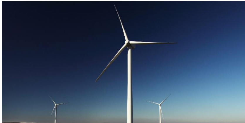
Figure 15: Une éolienne source: Éolienne domestique 2016
