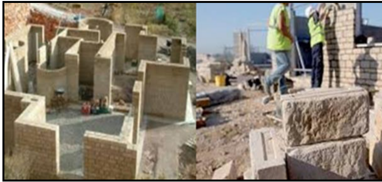
Figure 21: Les premiers Bétons et Briques en chanvre remontent à la fin des années 1980 Source : (Algérie-dz.com, 2017).
