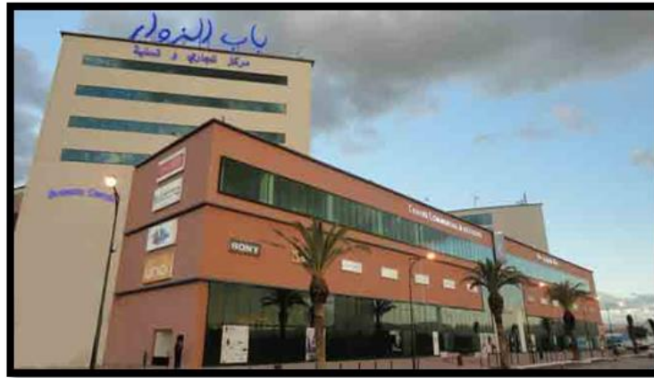
Figure n° :35: centre commerciale de Bâb ezzouar. Source : maghrebemergent(2018)
