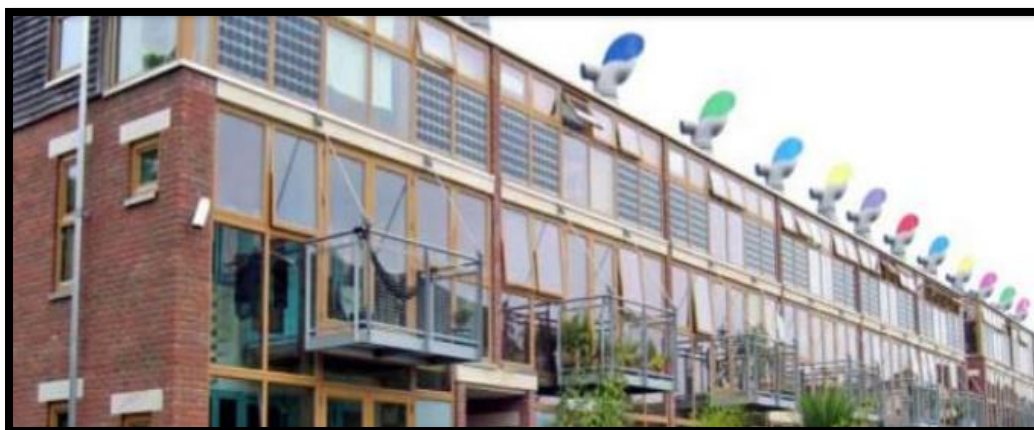
Figure44: façade d'un bâtiment du Quartier BEDZED.
