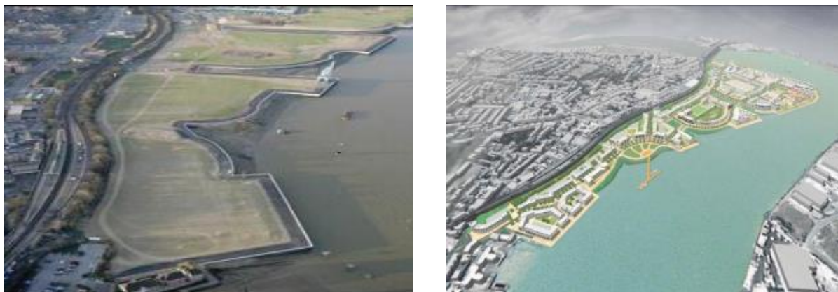
Image 14 : Vue générale sur la friche industrielle Rochester Riverside avant et après Réaménagement (Source : Kent, 2009).
