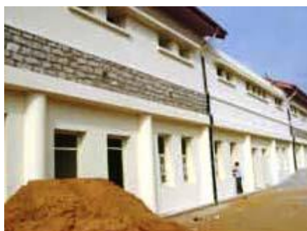
Image 31 : Vue sur la façade restaurée. . (Source Google image)
