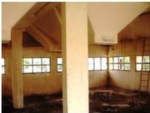
Image 21 : Vue intérieure sur les silos avant leur reconversion. (Source Google image)
