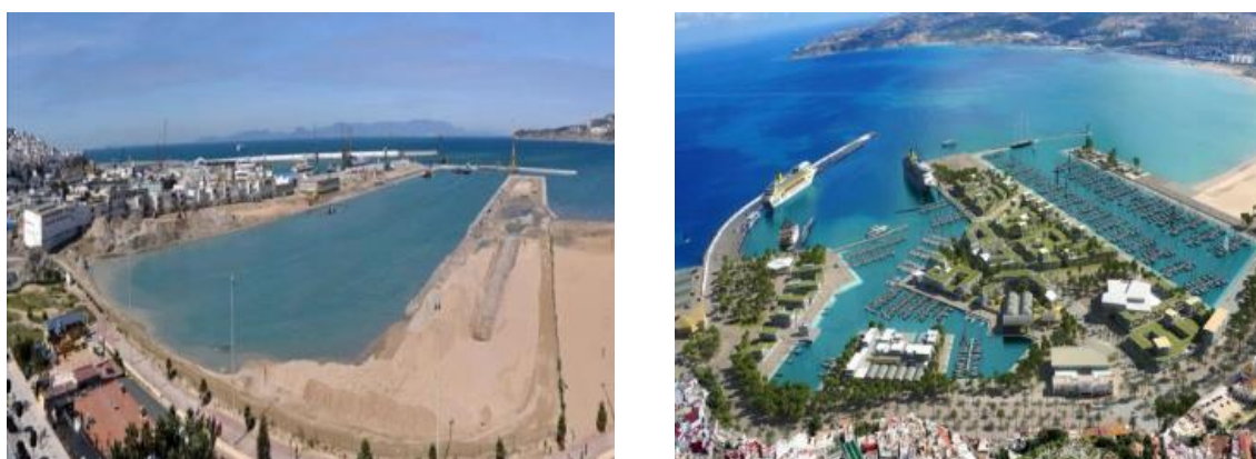
Image 15 : Vue générale sur le port de Tanger avant et après la reconversion Source : www.sapt.ma
