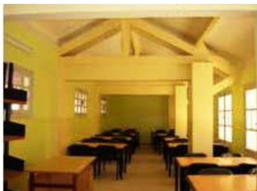
Image 28 : Vue sur la charpente réhabilitée. (Source Google image)
