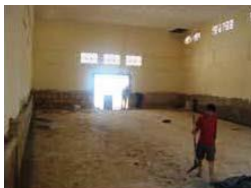
Image 16 : Etat de la cave pendant les travaux
