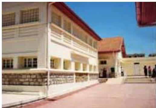
Image 23 : Vue sur les silos après leur réhabilitation. . (Source Google image)
