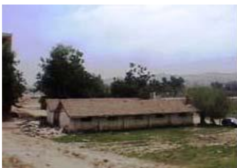
Image 27 : Vue sur les deux bâtiments de l'ancienne bergerie. (Source Google image)
