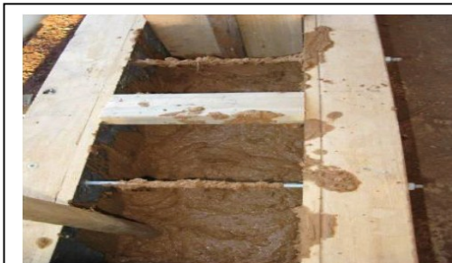
image 7. terre coulée dans le coffrage ; Source : N. BEKRI 2016
