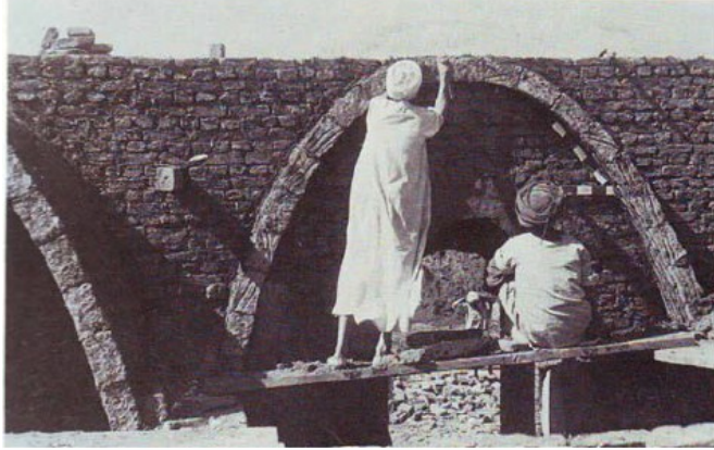
Figure 18.construire sans coffrage ; (Source : construire avec le peuple)
