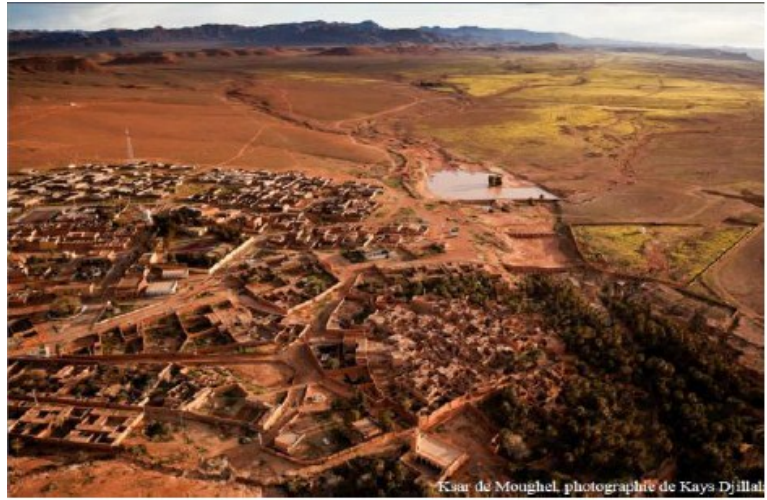
Figure 6..ksar de Moughel BECHAR (Source Pascal MAILLARD, Construire en terre : passé, présent, futur, PDF).
