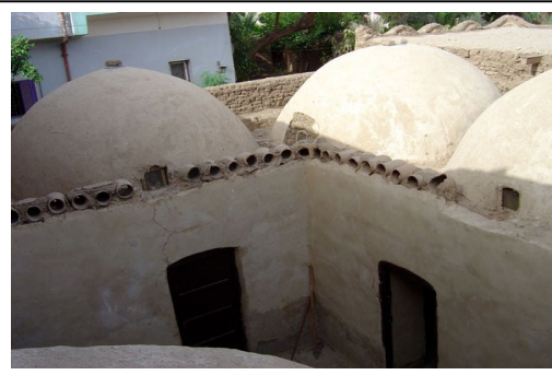
Figure 13. La technique de la voûte nubienne à l Gournia ; Source : Zarrouk CH
