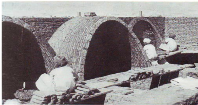
Figure 15. application du savoir-faire antique, méthode sans coffrage ; (Source : construire avec le peuple Ed : sindbad)
