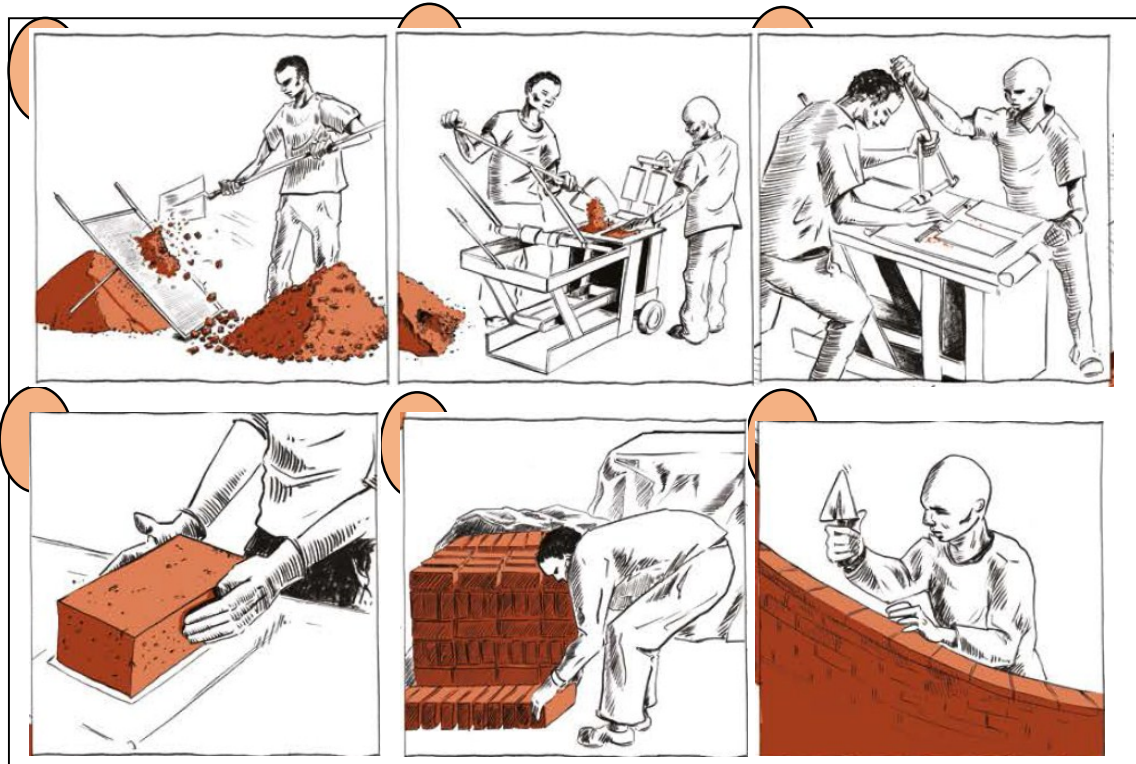
image 16.mise en œuvre de BTC ; Source : Pauline Sémon
