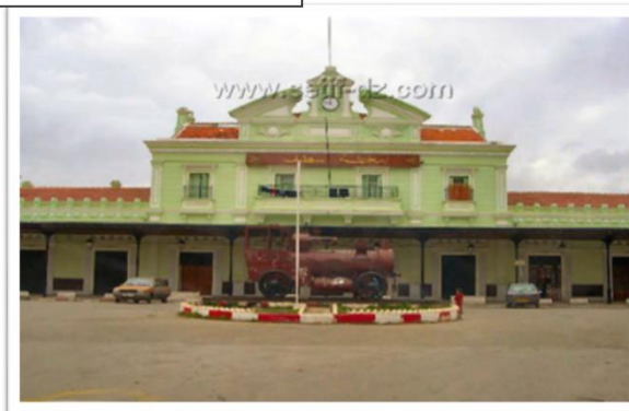
Photo N°05 : La façade et la place de la gare. Source : www.setif.dz.com
