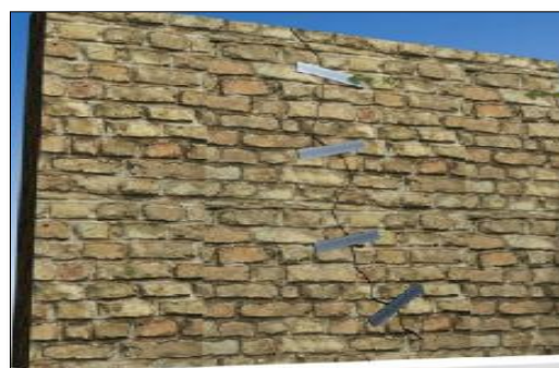
Figure 66 : épingle protégée ancré dans le mur pour renforcement Figure67 : remplacement des parties lézardées par des agrafes métalliques
