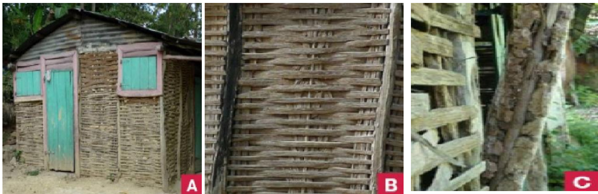
Photos29 : (a) ossature en bois avec clissage, (b) clissage, tressage, (c) clissage, mortier appliqué sur les deux côtés du panneau (© A. Caimi)
