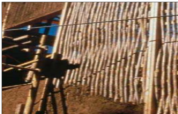
Photo21 : Mur en bambou et terre
