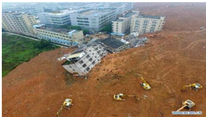
Photo14 : Mouvement de terrain dans une zone d'habitation.
