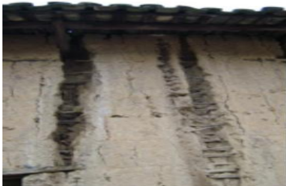
Photo27 : Renforts horizontaux des murs
