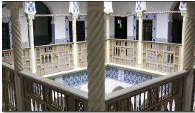
Photo 39 : arc de contreventement Palais des Rais
