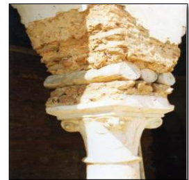
figure31 : Superposition perpendiculaire de rondins
