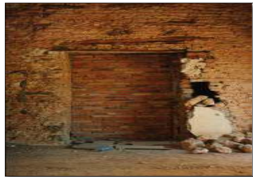
Photo37: les différentes couches du mur
