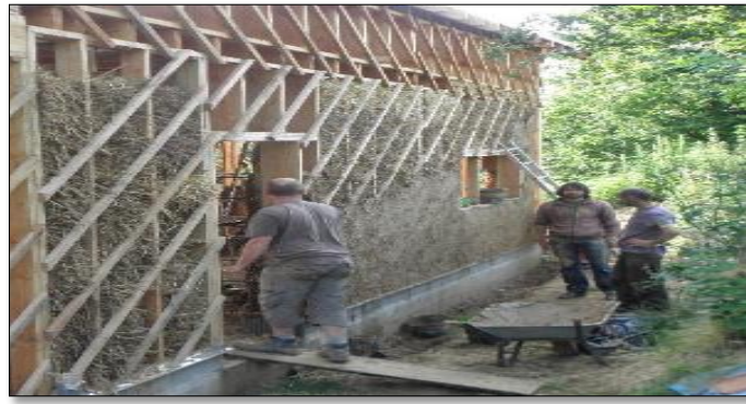
Photo 3: préparation de Torchis Source : www.futura-sciences.com
