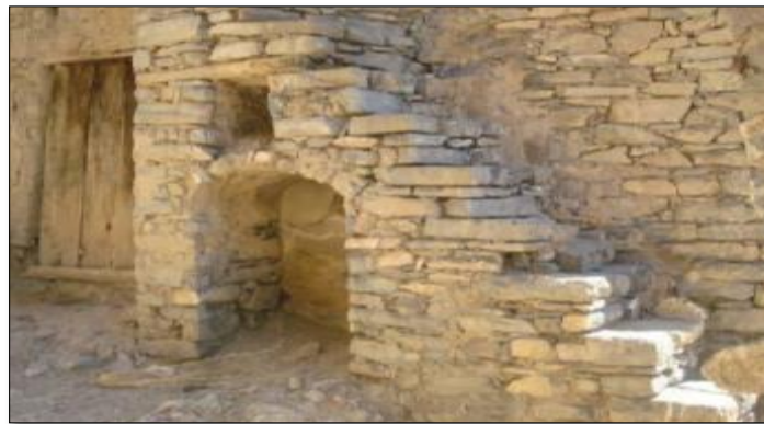
Photo 36 : Vues sur les escaliers droits village Boudjlil, Bejaïa
