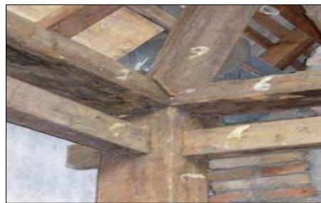
Photo23 : Connexion poteau charpente 41
