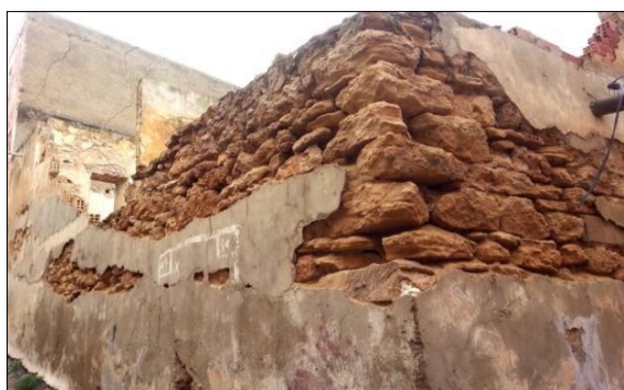
Photo32 : Mur à Tigditt Chaînage d'angle
