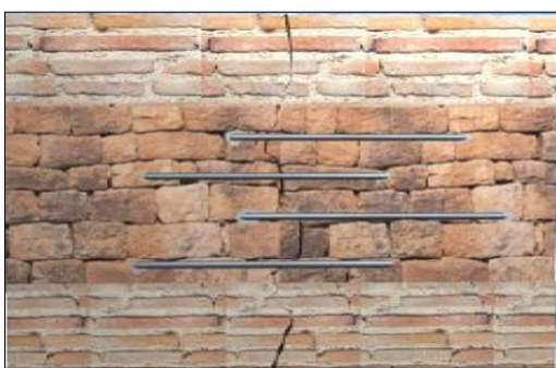
Figure 66 : épingle protégée ancré dans le mur pour renforcement Figure67 : remplacement des parties lézardées par des agrafes métalliques
