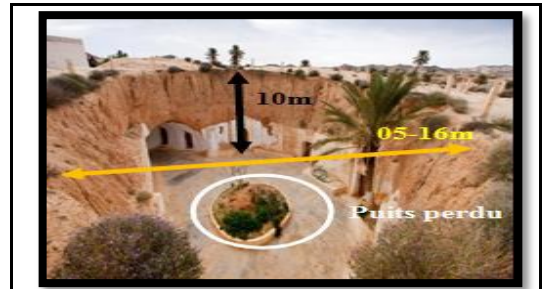
Figure III.7: Dimension de la cour d'une maison troglodyte de Matmata
