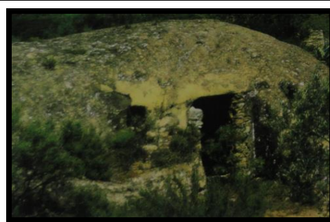
Photo II.6 : abri agricole monolithe creusé dans la roche (Beaumes-de-Venise, Vaucluse).
