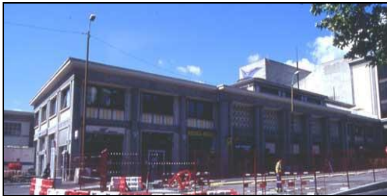
Figure n° :04: gare routière de Clermont Ferrant Source : Khalfi, (2012).
