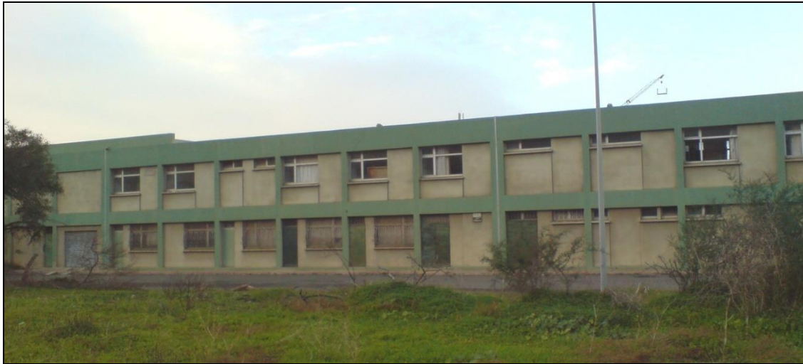
Figure n°:63: gare de Jijel façade sud
