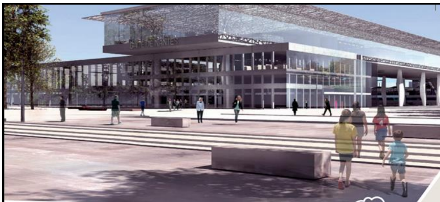
Figure n° :32: façade principale de la gare de Nantes. Source : Gian grande, (2013)
