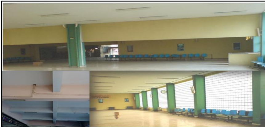
Figure n°:61: structure utilise dans la gare de Jijel
