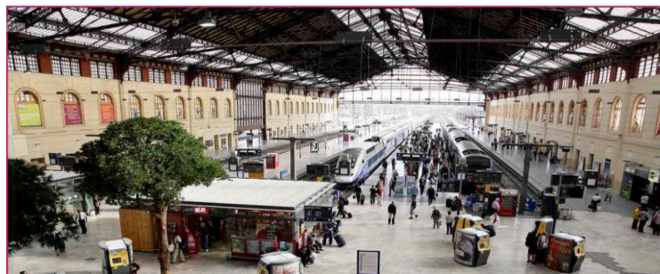
Figure n°:52:double halle de la gare Source : Setec Tpi, (2002)
