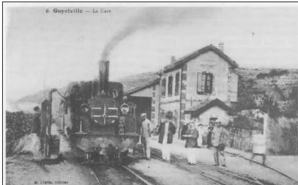
Figure n° :26: la gare de Guyot ville. Source : Arrivetz, (1988)
