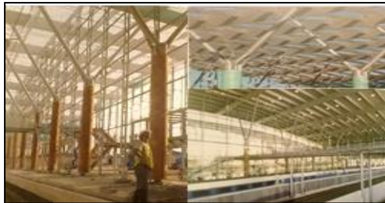
Figure n° :06: la structure d'une gare TGV à Aix-en-Provence Source : groupe moniteur, (2002)
