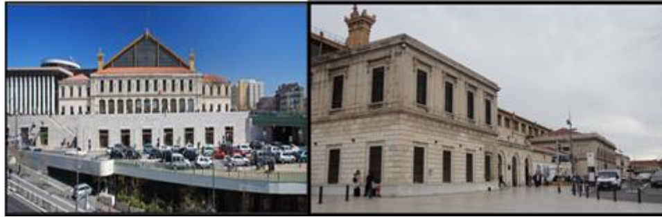
Figure n°:50:façade de la partie ancienne de la gare Source : LGV PACA, (2008)
