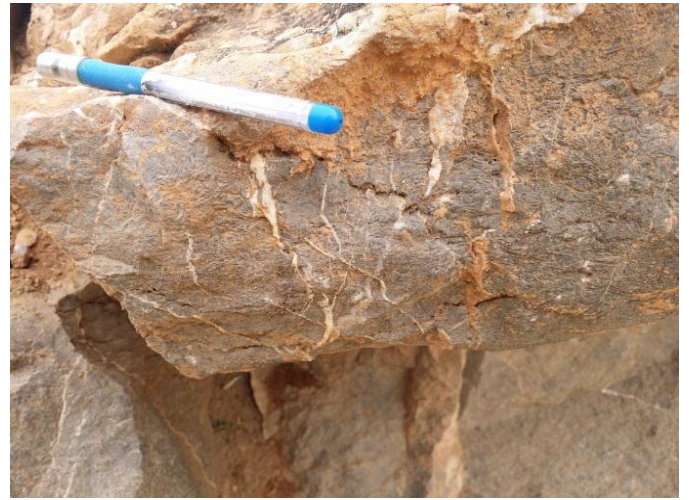
Fig. 2 : Un banc de calcaire fracturé et traversé par des fentes de tension
