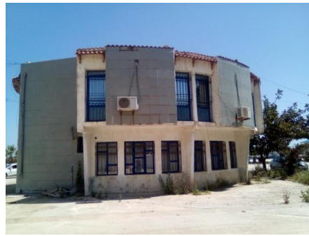
Photo IV.3 : La façade Sud-est
