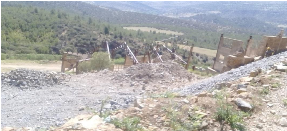
Fig.VI.2: Photo de l'ancienne station de traitement d'Ichmoul (Lariane H. Khoualed A. 2018)
