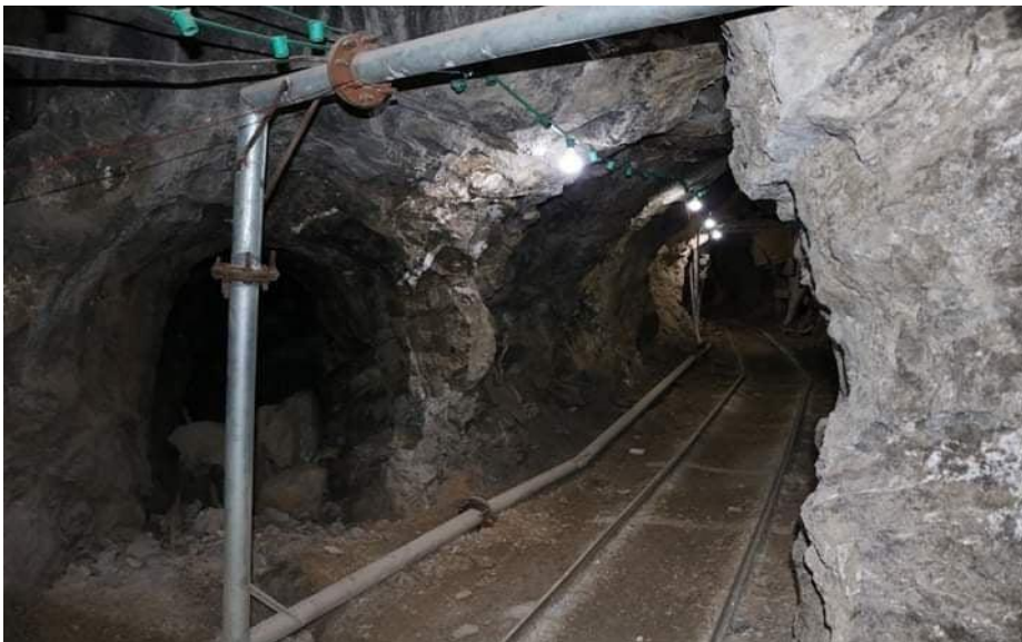
Fig.VI.7 : Photos montrant les galeries d'acheminement du minerai (ENOF Ichmoul 2019)
