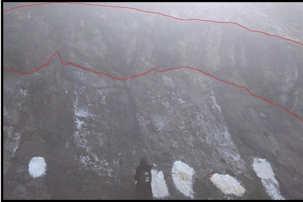
Figure.II.5. Plan horizontal et vertical de discontinuité
