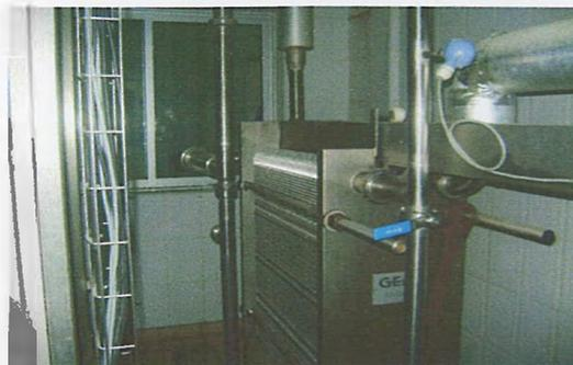
Figure 30. Refroidisseur à plaques.
