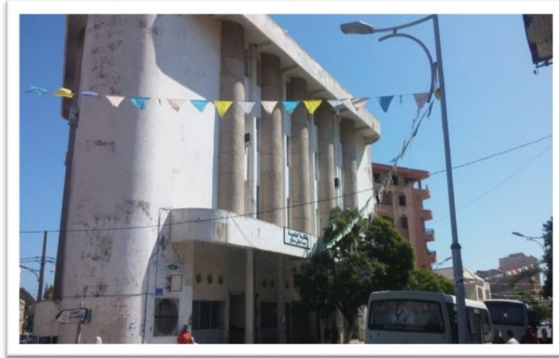
Figure IV.6 : la façade principale de bibliothèque municipale (Source: auteur)
