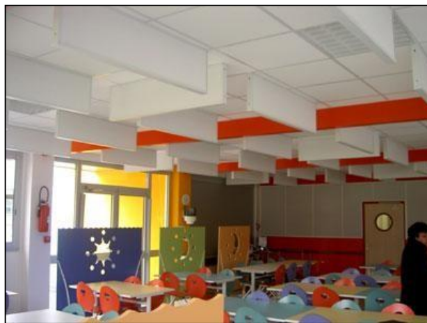
Figure III- 10. Traitement acoustique du plafond en baffles acoustiques (Source: www.euphonie.fr )
