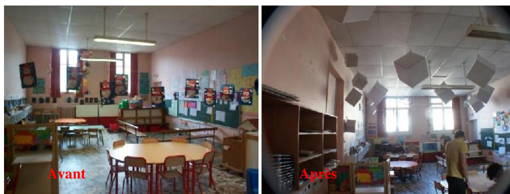
Figure III- 8. Exemple d'un traitement acoustique de la salle (Source: Semidor Catherine, 2003)
