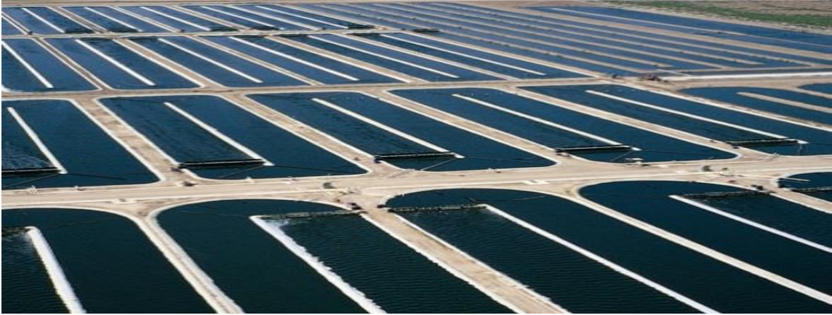
Figure 03: Photo d'un étang de raceway [69].
