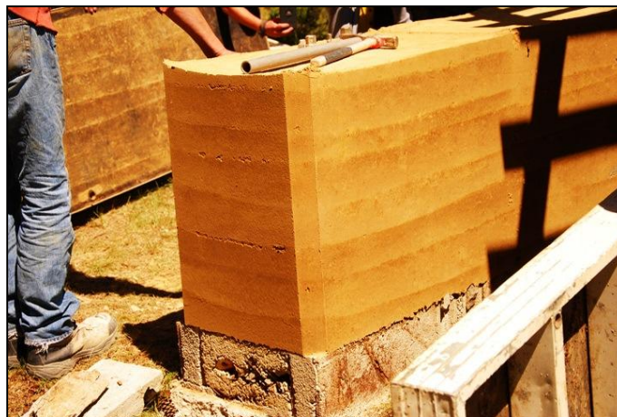
Figure 31: Construire en pisé Source: Construction21, (2017).
