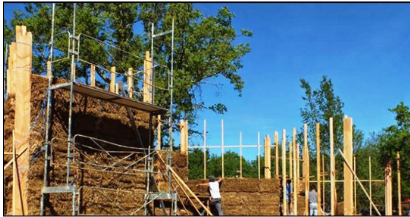
Figure 34: Ossature en bois avec isolation en paille. Source : La voix d'Algérie, (2017).
