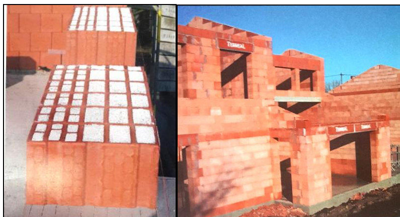
Figure 12: Briques monomur en terre cuite. Source : Courgey et Oliva, (2008).
