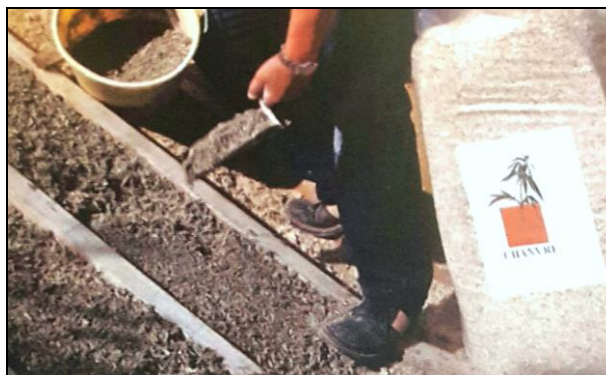
Figure 10 : La pose de la brique de chanvre Source : Ader, (2010).
