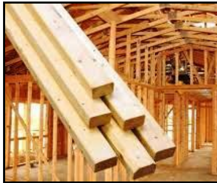
Figure 22: Maison écologique avec ossature en bois, Source : Tour, (2010).
