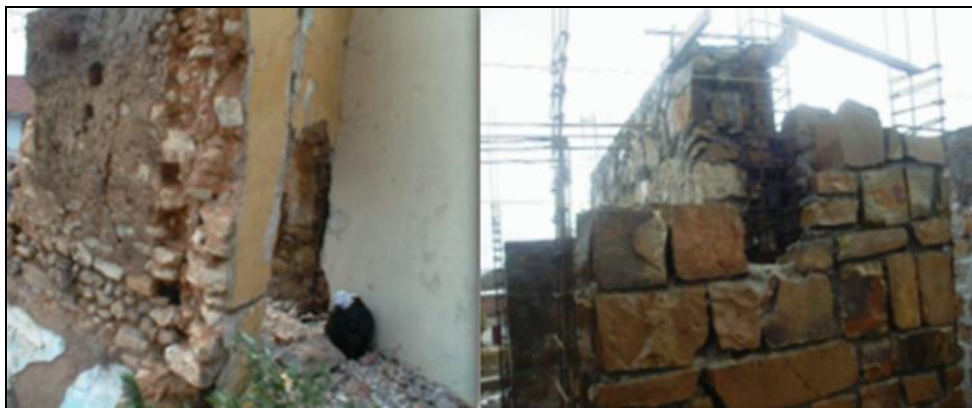
Figure 25 Bâtie ancien (gauche) et bâtie récent (droite) en moellon de pierre Source: Benouali, (2015).
