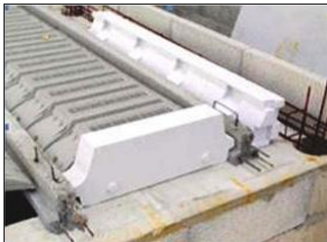
Figure 46: l'utilisation des épingle. Source: BET DAR, (2018).
