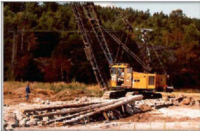
Figure I-27 Pieux en bois.
