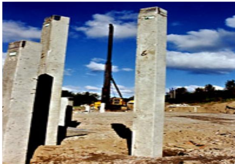
Figure I-29 Pieux en béton.
