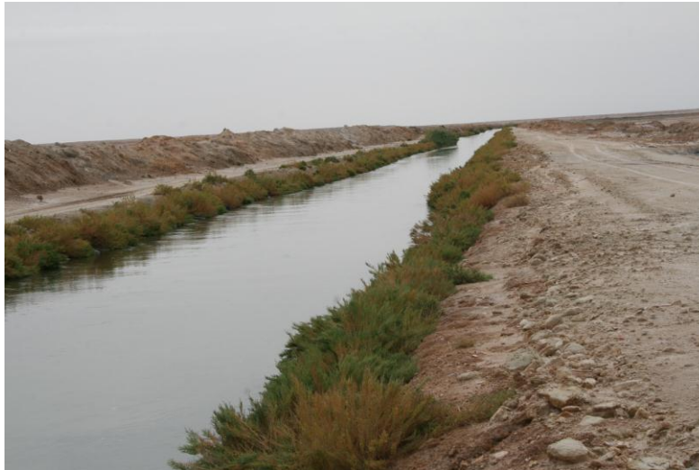
Figure 17 : Canal de drainage d'oued Righ
