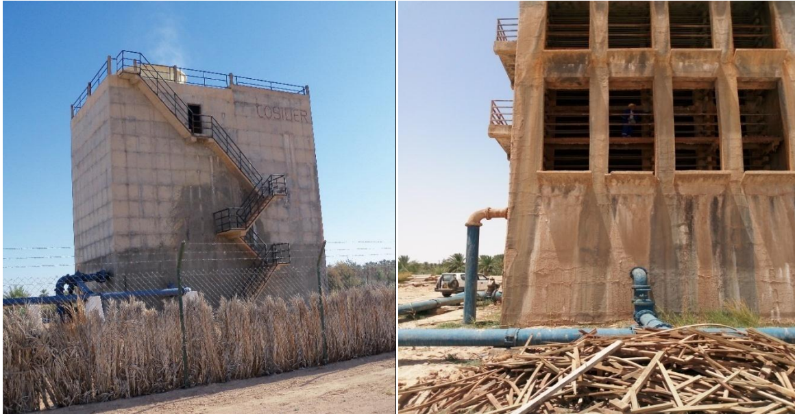
a) Tour de refroidissement en fonctionnement.
